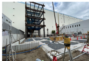
鉄骨建方での活用風景
