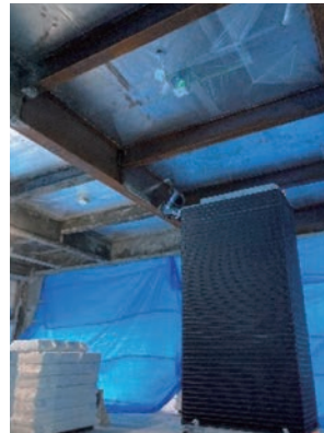
耐火被覆吹付ロボットによる現場施工
