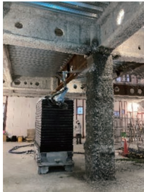
耐火被覆吹付ロボットによる現場施工
