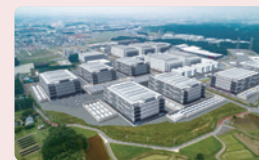
データセンター
