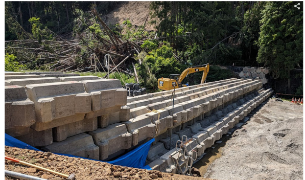
【対策工事の一例（ブロック堰堤）】
