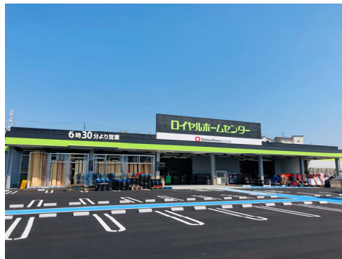
【ロイヤルホームセンター日進香久山】
